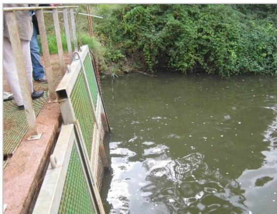
Le pompage dans la fosse d'aspiration est réalisé par 4 pompes de 1 600 m<sup>3</sup>/h, fonctionnant par alternance.
