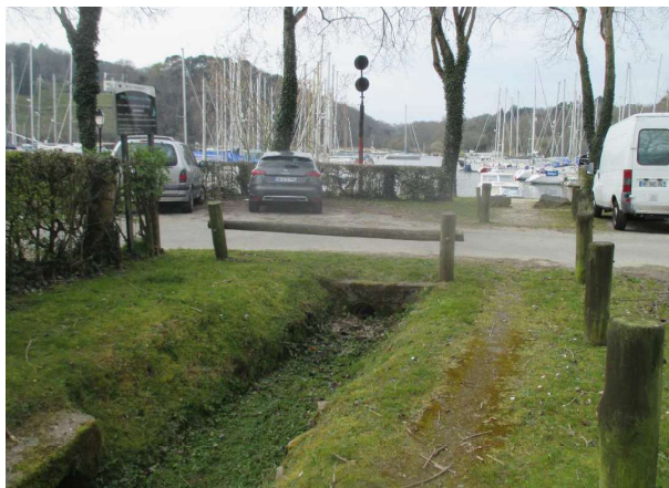
Exutoire pluvial en Vilaine (vue amont)
