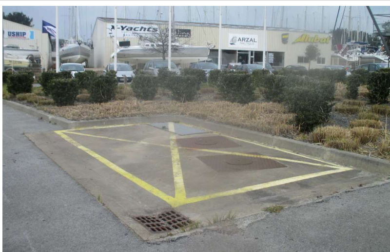
Double cuve enterrée et zone de dépotage « Carburants » à terre
