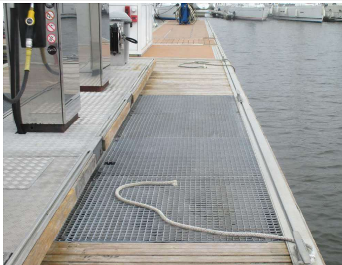
Station « Carburants » en bout de Ponton A
