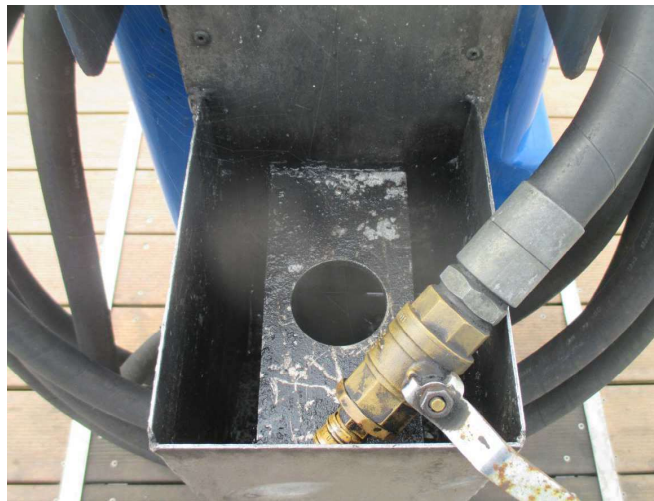
Bac de récupération embout Huiles usagées de la station « Bateau Propre »
