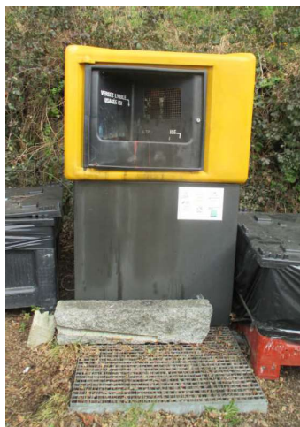
Colonne de collecte des huiles sur rétention dans la zone technique du port
