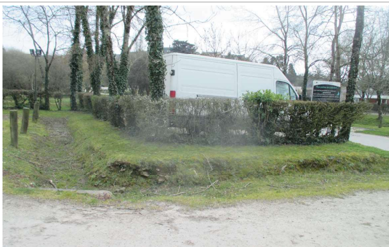
Système de « noues » sur la zone parking VL
