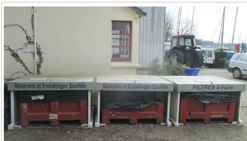
Aire de tri sélectif des déchets dans la zone technique du port
