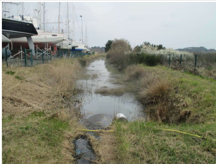
Bassin tampon de décantation des eaux pluviales
