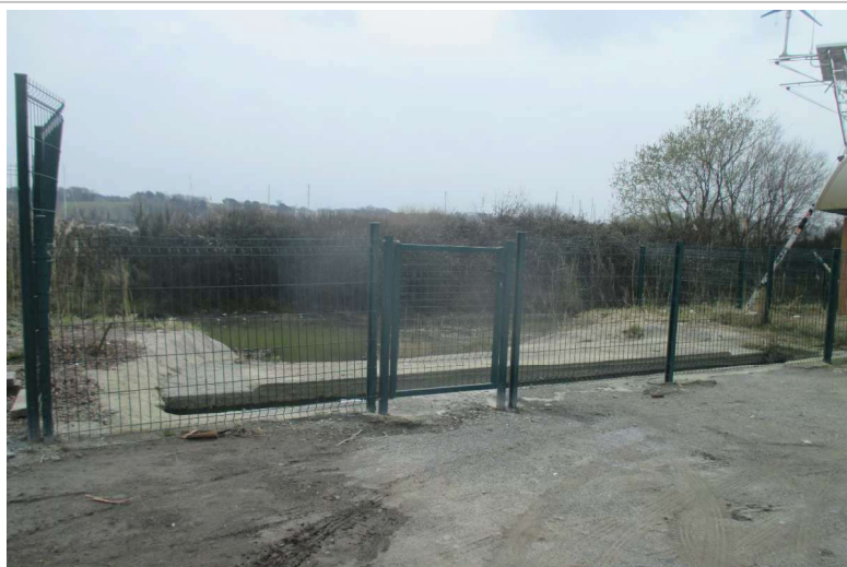
Caniveau de collecte d'une partie des eaux pluviales de la zone technique en amont du bassin
