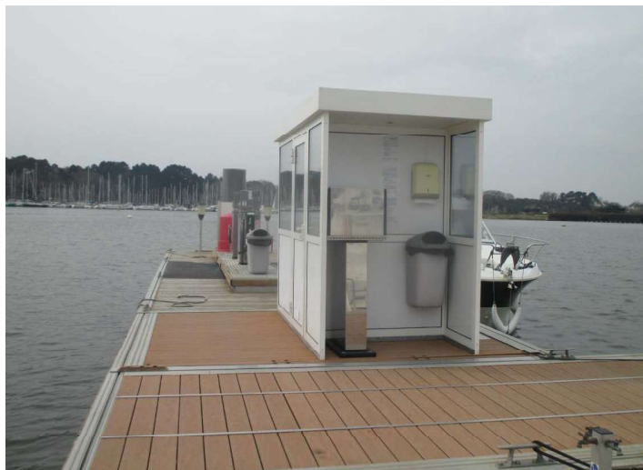
Station « Carburants » en bout de Ponton A
