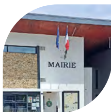
Entretien, aménagements et mise en conformité bâtiments publics : 137 860 €
