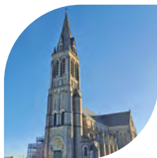
Restauration de l'église : 831 062 €
