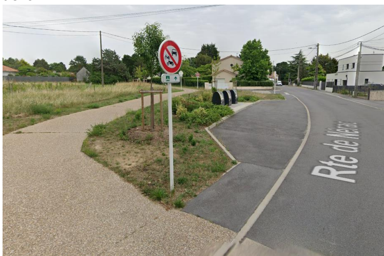
Illustration 2 : Exemple d'une aire de collecte permettant de limiter l'impact sur la circulation lors de la collecte
