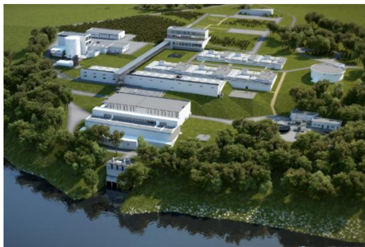
Illustration n°5 : vue aérienne des nouvelles installations de l'usine de production d'eau potable de Vilaine Atlantique. Source : rapport de présentation p.57
