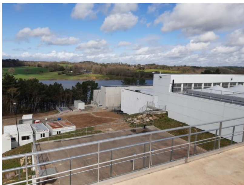
Vue de l'usine de production d'eau potable de Férel
